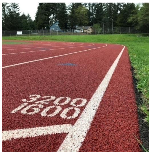
Figura 35: Detalhe da Pista
